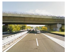
Val Freghizia Bridge (IT)
